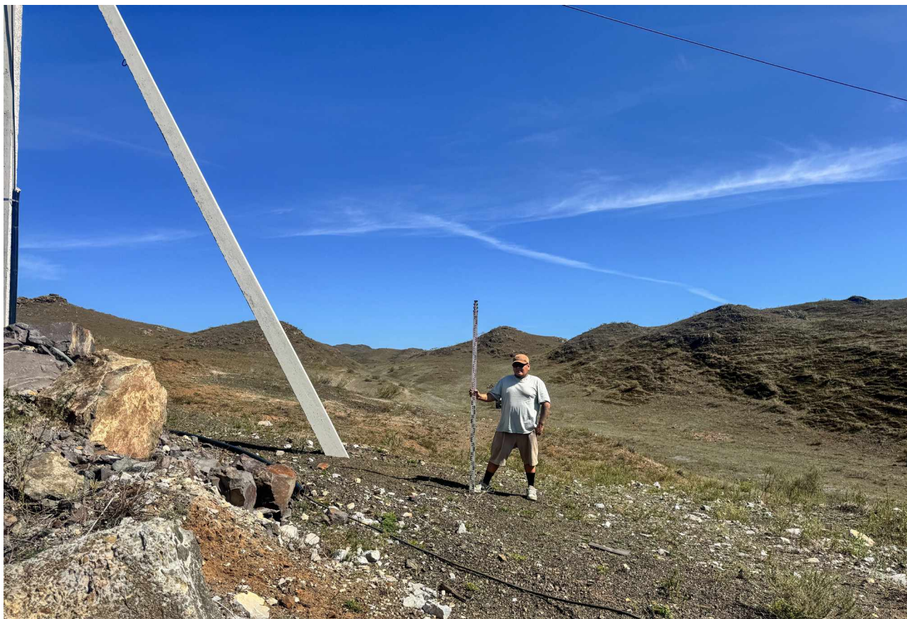
Рис. 16. Мостовой переход. Вид на территорию проектирования от точки видовой фотофиксации №1 с запада.
